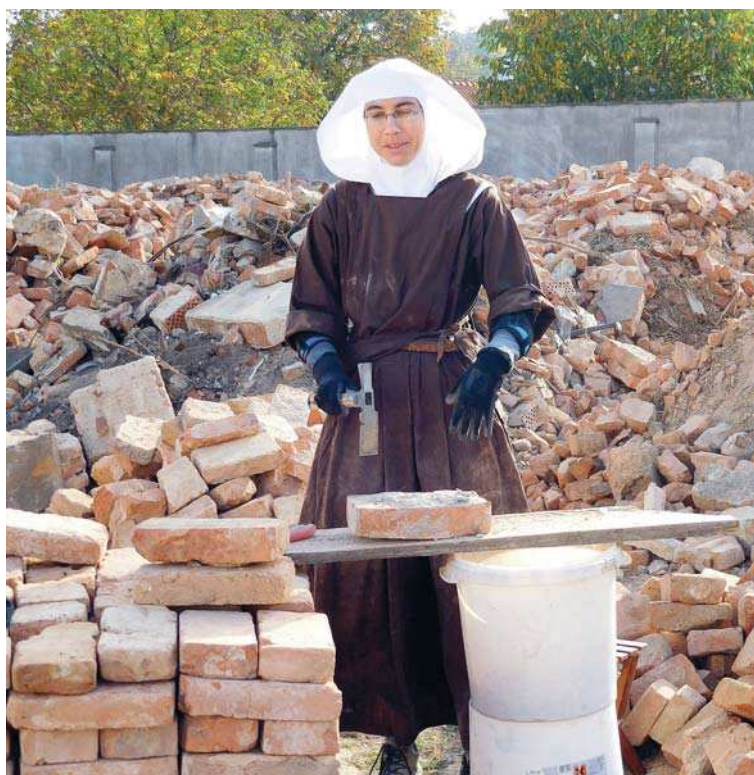
Čištění cihel. Ještě se budou hodit.
