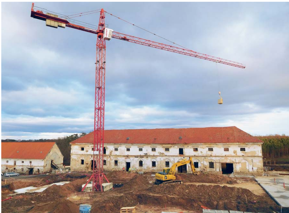
Začátek stavby kláštera, leden 2022.
