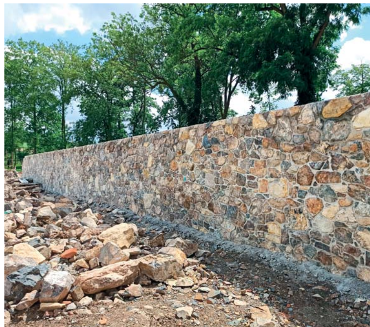
Stavba klauzurní zdi u lesoparku, jaro–léto 2022.
