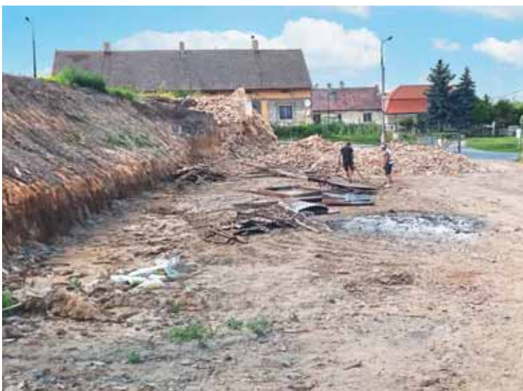
Demolice spodní opěrné zdi a menšího domu u spodní brány letos v létě.
