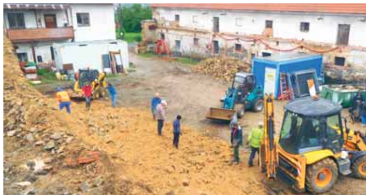
Demolice opěrné zdi. V pozadí je ovčín, kterého rekonstrukce teprve čeká.
